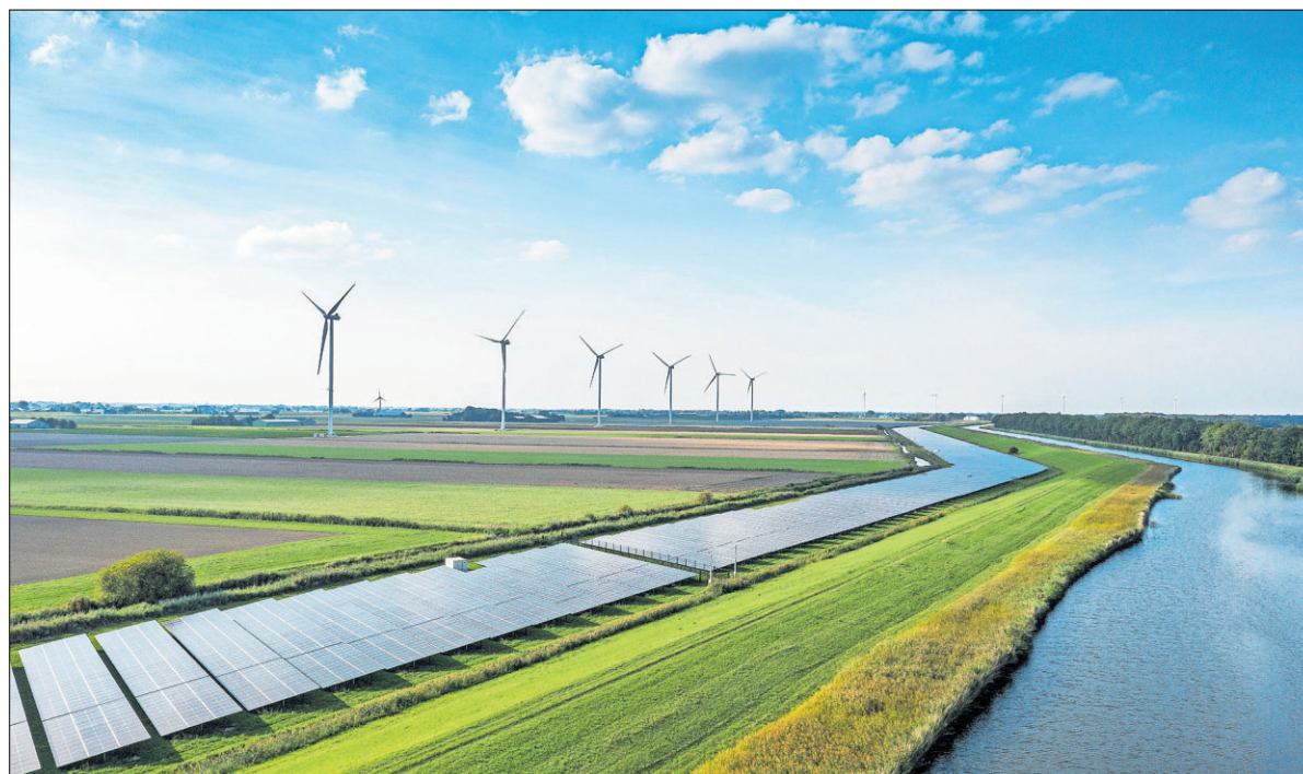
In Österreich wird ein Großteil der Energie bereits durch Windräder und Solaranlagen erzeugt.
