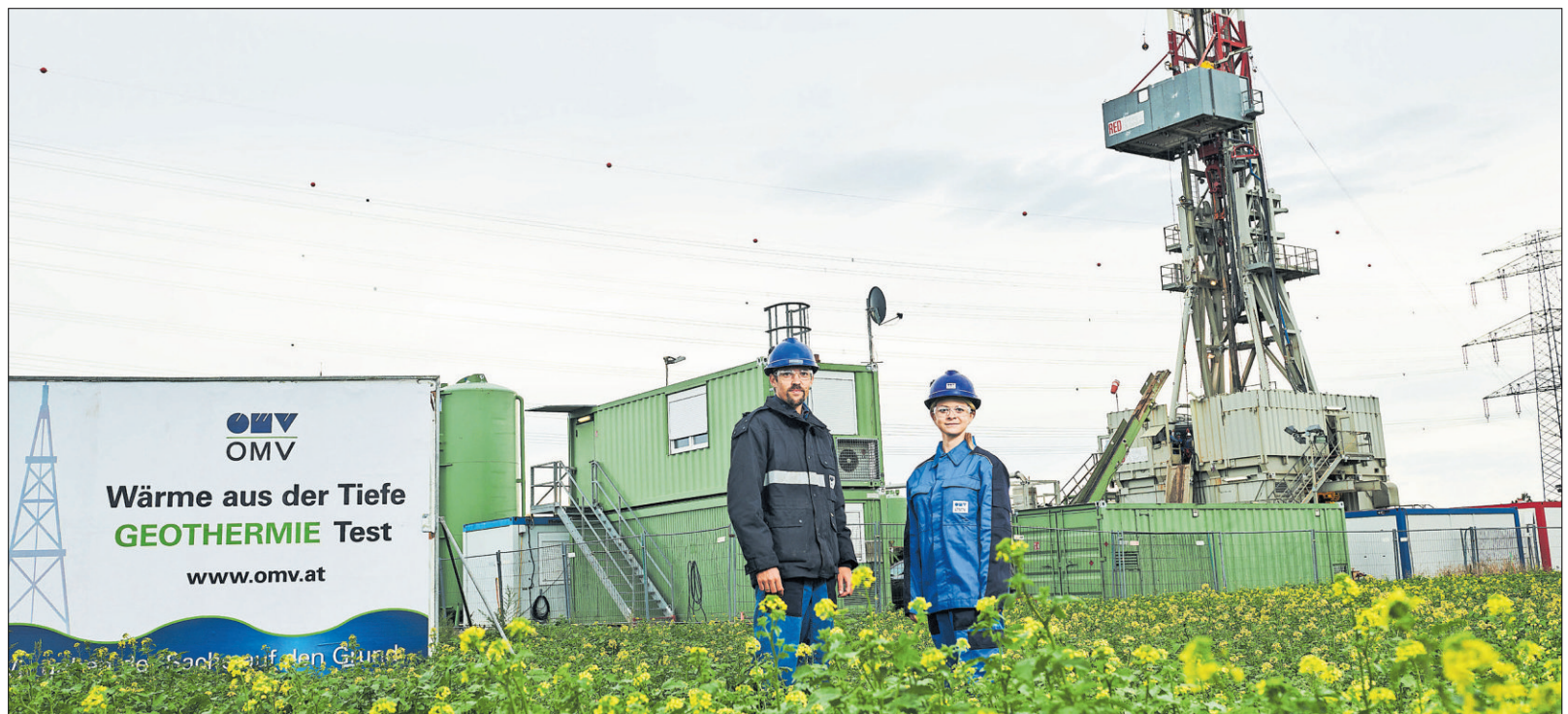
Bei der Geothermie wird Wasser nach oben befördert, die Wärme entnommen und das Wasser wieder in die Tiefe gepresst.
